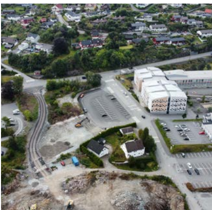
Planlegges: Kleppevegen ved Myrane. Foto: Askøy kommune
