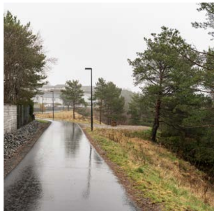
Ny gang og sykkelveg mellom Såtabu og Helsehuset i Alver Foto: Thor Brødreskift
