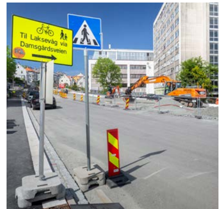
Under bygging: Sykkelfelt og fortau i Carl Konows gate. Foto: Silje Drevdal
